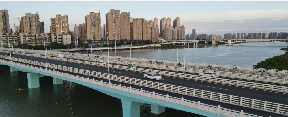
7月1日,国道G324线泉州大桥及接线扩宽改造项目工程完工通车。
