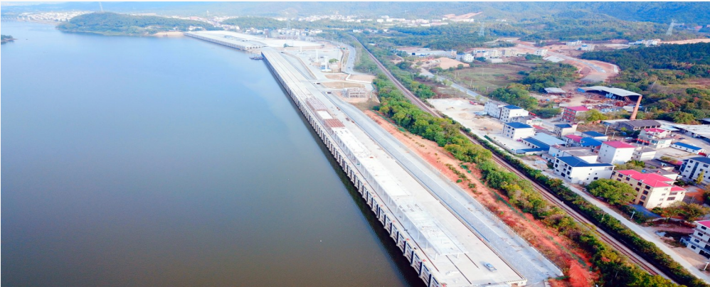
2023年10月,景德镇市鱼山码头项目义城作业区9-14号泊位现场,8台40吨门机机械部分全部完成安装。
