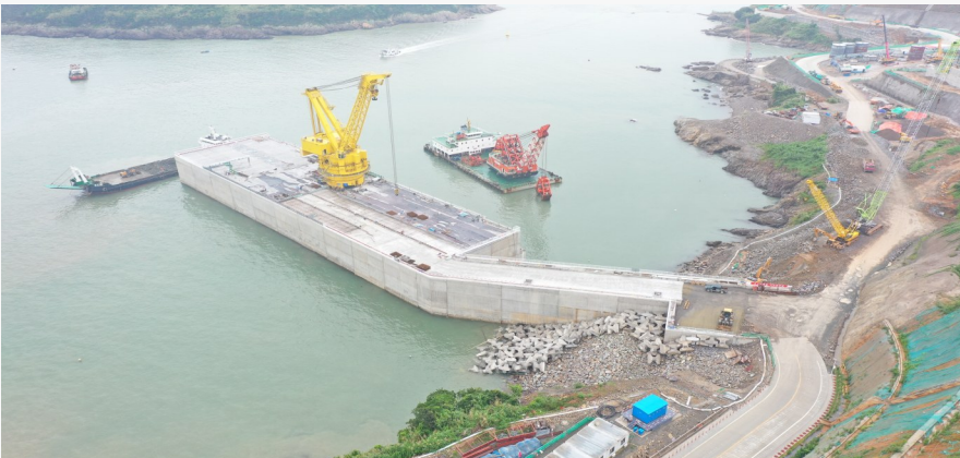
6月29日,浙江三澳核电项目一期大件码头工程主体结构主体完工。
