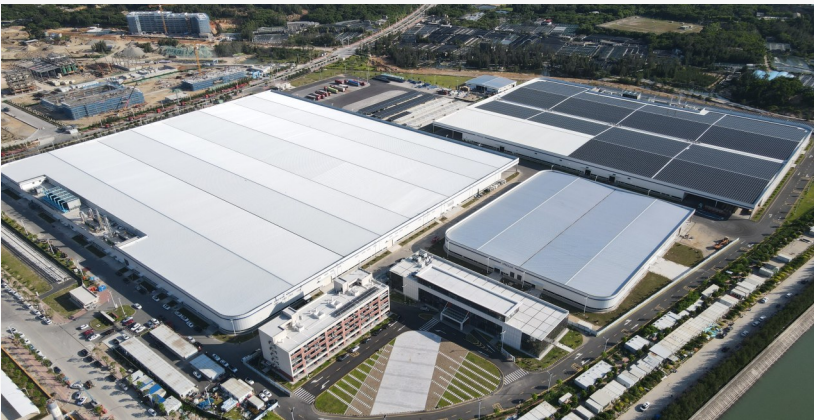
5月22日,一道新能源光伏组件项目二期工程提前完成厂房钢结构、管线安装全部任务。
