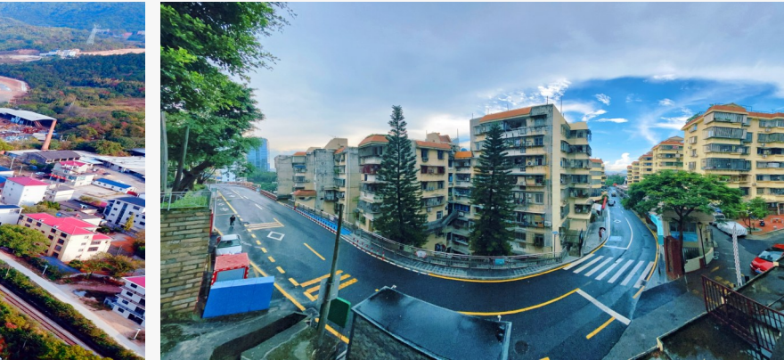
厦门市湖里区东渡片区城市更新项目为居民幸福生活加码。
