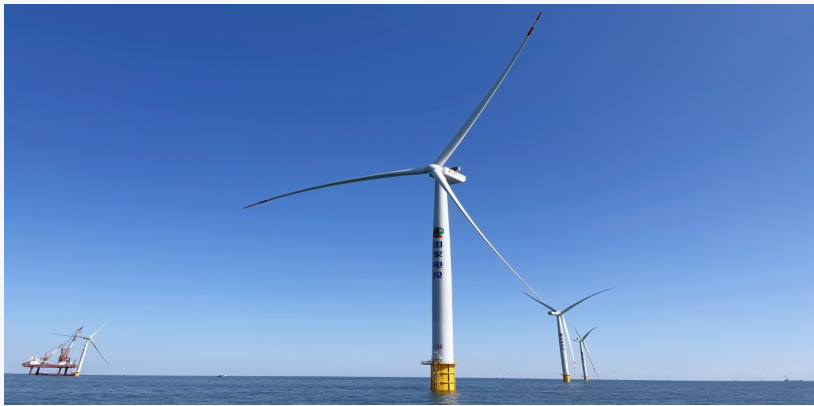
11月17日,国家电投山东半岛南U场址一期450兆瓦海上风电场项目实现全容量并网发电。
