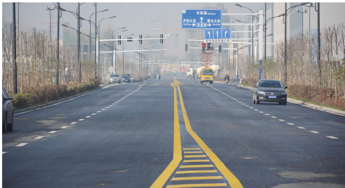
12月20日,分公司承建的临庐产业园(起步区)整体城镇化建设二期工程PPP项目正式通过竣工验收。该项目包含腾飞路管廊、富泉路管廊工程及道路工程,作为临泉县第一批竣工验收的管廊项目,标志着临泉县正式迈入“管廊时代”,为园区内各企业使用给水、污水、电力、通信等提供了有力的保障。(梁毅 吕彪)
