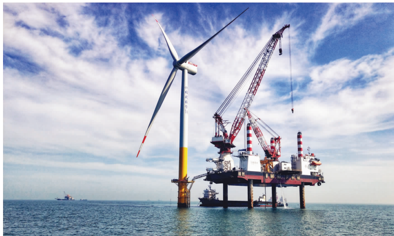
▲2019年4月,莆田平海风电二期I标段项目顺利完成首台超大型风机安装作业。(吴文明)
