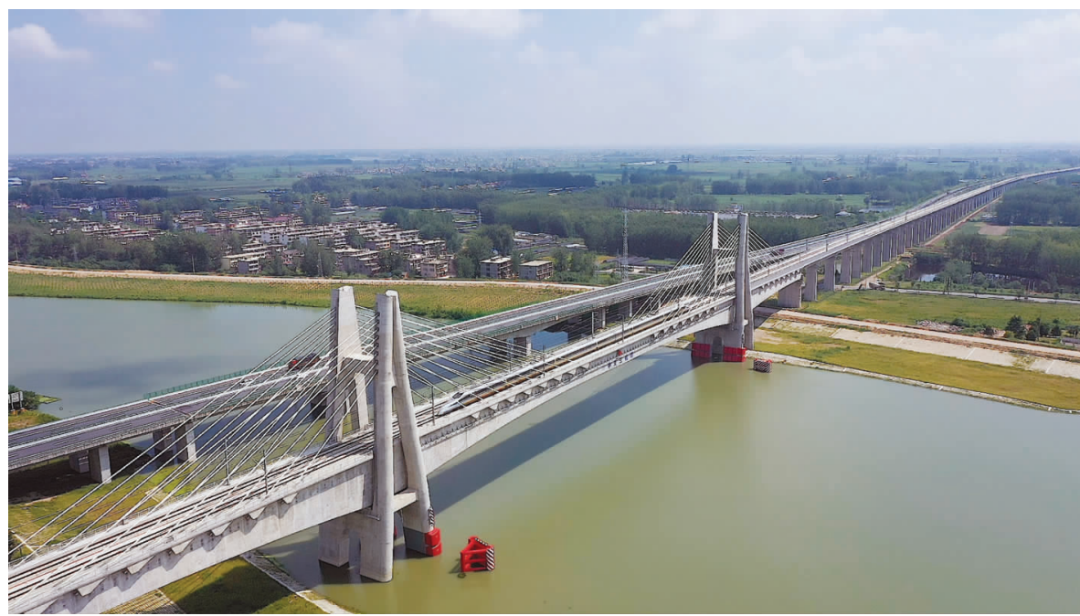
▲2019年12月1日,分公司参建的商合杭高铁合肥以北段正式通车运营。(赵光)
