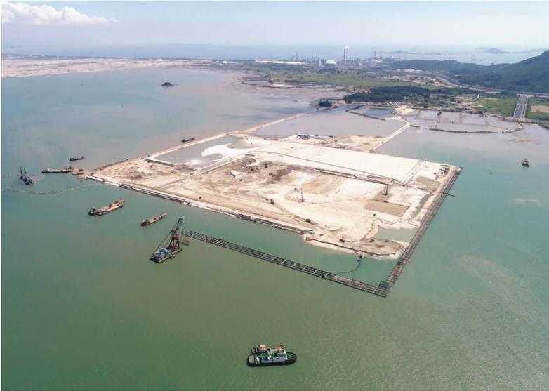
近日,随着第 59 件沉箱精准定位安装,分公司厦门港古雷港区古雷作业区北 1 号、2 号泊位工程 1 号泊位沉箱全部安装完成,比原计划提前 15 天。项目建成后,对促进石化产业园区开发,加快推进闽西南经济协作区建设,构建布局合理、衔接顺畅、服务高效的交通网络具有重要意义。(赵辉辉)
