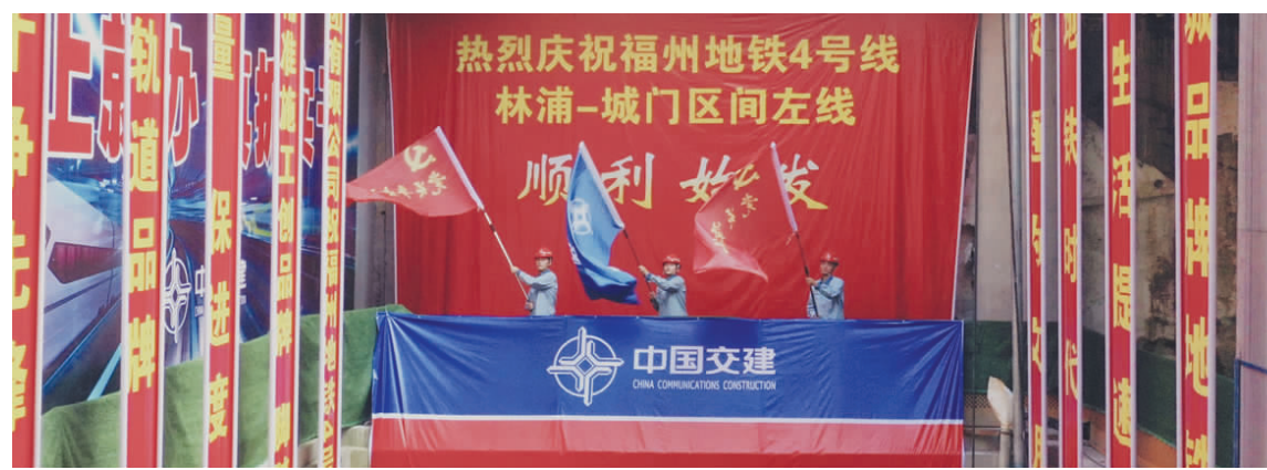
近日，福建省首台暨中交集团、三航局首台TBM-EPB双模盾构机——“三航盾6”在福州地铁4号线林浦站-城门站区间左线顺利始发掘进，标志着分公司在盾构施工领域技术、经验再上新台阶。(罗志鹏)
